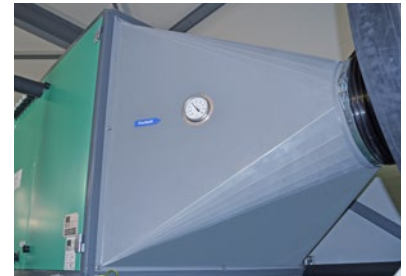
Fertigung und Montage von Lüftungskomponenten aus PP
