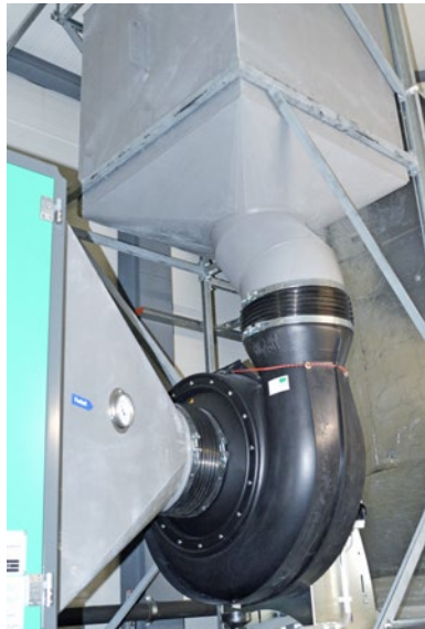
Fertigung und Montage von Lüftungskomponenten aus PP
